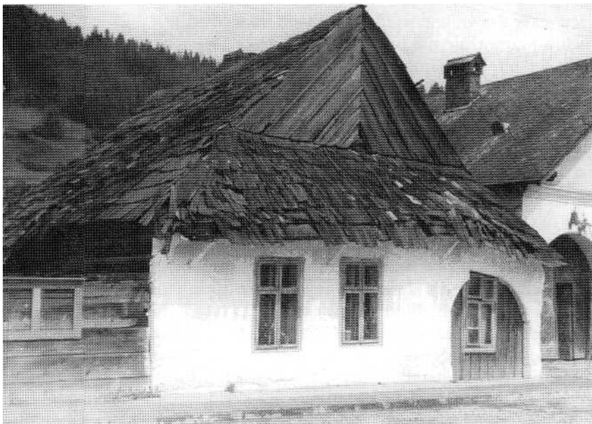
Dom Bębynków. Stan z 1958 roku. Dom rozebrano wiosną 1964 roku.
