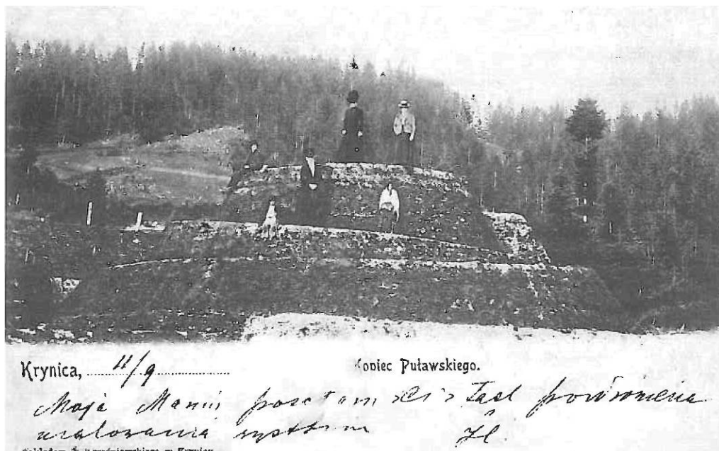
Kopiec Puławskiego w budowie — pocztówka z 1901 roku
