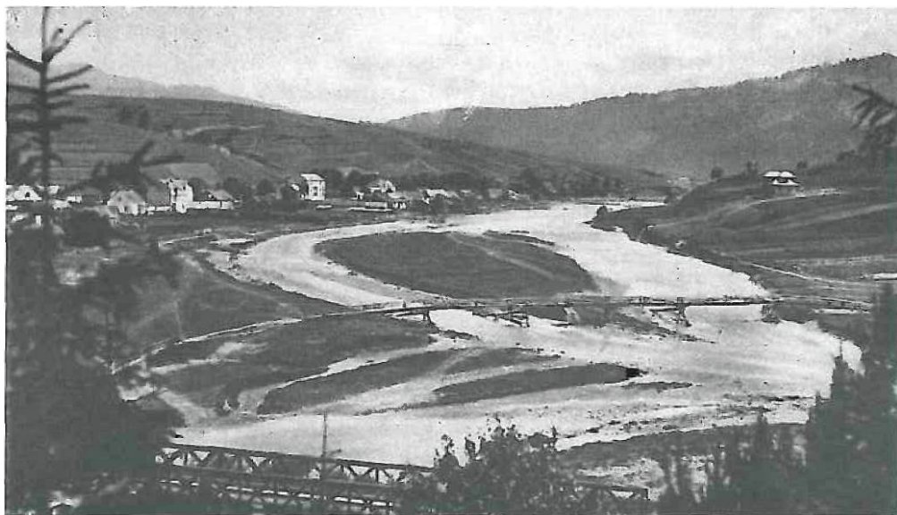
Most na Popradzie (początek lat dwudziestych)
