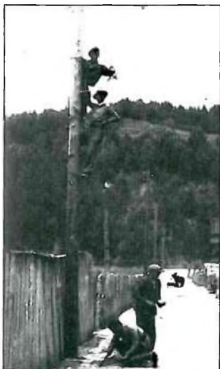
Budowa sieci elektrycznej
