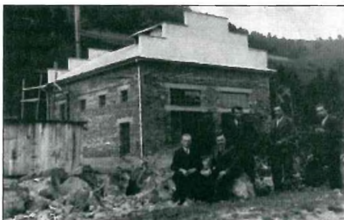
Budynek elektrowni w budowie
