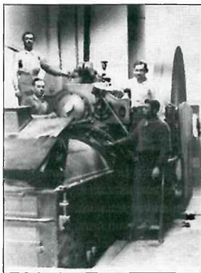
Elektrownia – lokomobila (wszystkie fotografie z archiwum autora)
