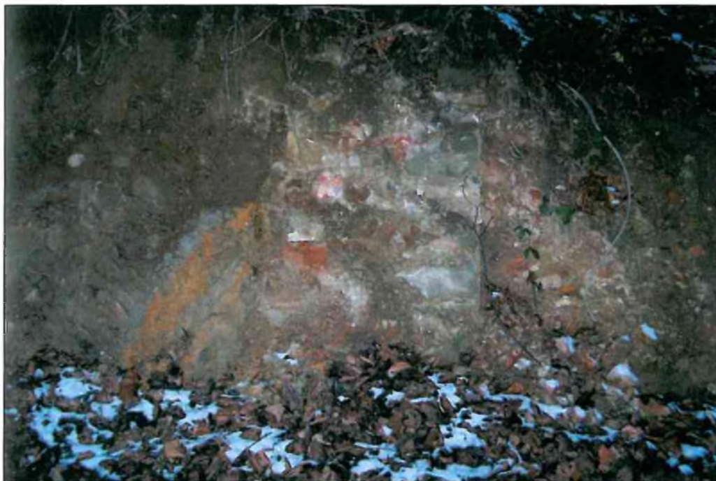
Fragment murów z cegły i kamieni, odkrytych na zboczu Góry Zamkowej, przy pracach drogowych nad Muszynką (fot. B. Rucka, jesień 2004)
