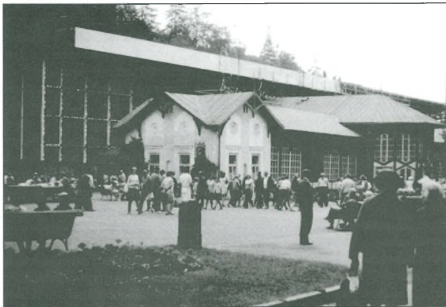
Unikalne zdjęcie przedstawiające budowę nowej pijalni w Kryńcy. Przed nią budynek starej, przeznaczonej do rozbiórki XIX-wiecznej pijalni. WSSE sprawowała specjalny nadzór nad wszelkimi nowymi obiektami powstającymi w małopolskich uzdrowiskach, m.in. poprzez opiniowanie projektów z punktu widzenia sanitarnego. Zdjęcie z sierpnia 1968 r. wykonane przez przebywającego na kontroli w Kryńcy docenta Mieczysława Bileka.
