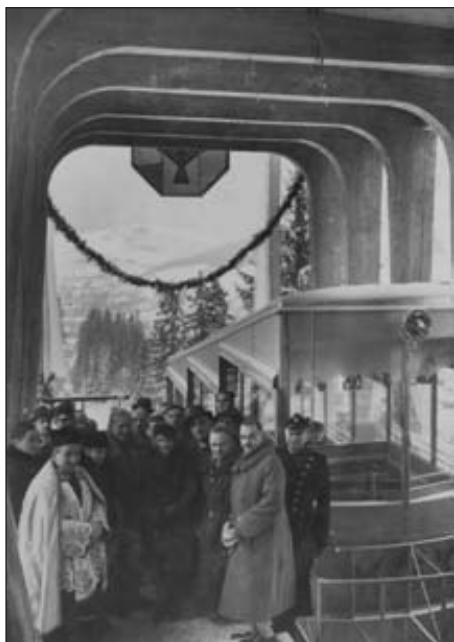
19 grudnia 1937 r. Po poświęceniu kolejki. Pierwsi goście na górnej stacji. Fot. St. Mucha. Udostępniona dzięki uprzejmości PKL Góra Parkowa za pośrednictwem Piotra Ruckiego
