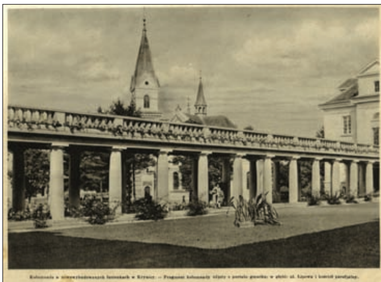
Kolumnada w nowo wybudowanych łaźnienkach w Krynicy. Fragment kolumnady zdjęty z portalu gmachu; w głębi ul. Lipowa i kościół parafialny. [Fot. z rozdziału Uzdrowiska , podpis oryginalny]
