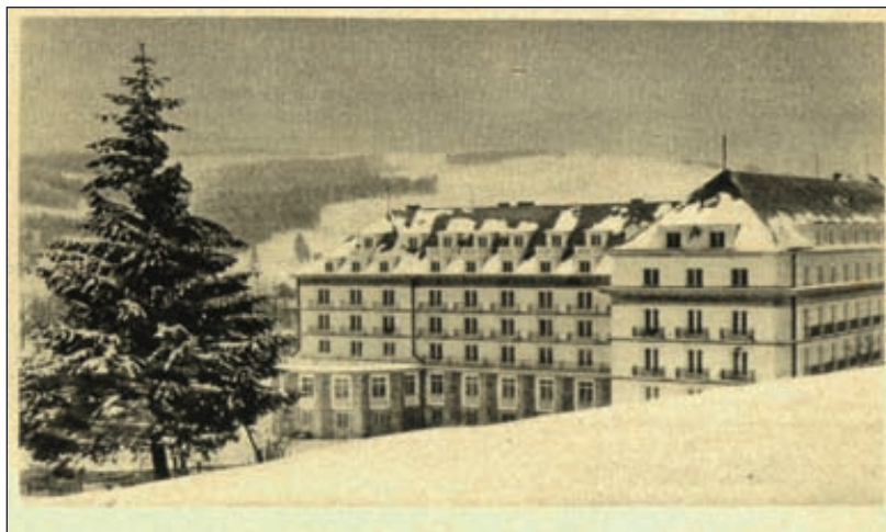
Hotel - Pension „Lwigród” Zakładu Ubezpiecz. Prac. Umysł. we Lwowie. Gmach, wykonany w r. 1928, jest największym tego rodzaju hotelem uzdrowiskowym w Polsce. [Fot. z rozdziału Uzdrowiska , podpis oryginalny]
