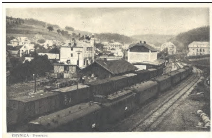
Początek lat 30. Budynek stacji Krynica przed przebudową. Pocztówka ze zbiorów „Almanachu Muszyny”
